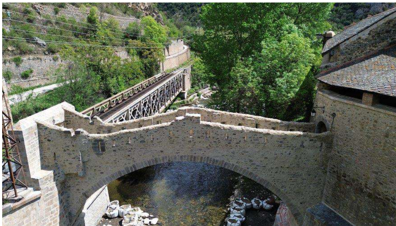
Pont Saint Pierre après travaux
