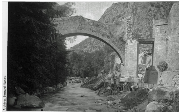
Dès le départ de la ligne, les remparts de Villefranche sont un obstacle à franchir. Une trouée dans la muraille défensive du pont Saint-Pierre doit être percée afin de permettre à la voie de chemin de fer de partir à l'assaut du Conflent, et au-delà, atteindre la Cerdagne.
