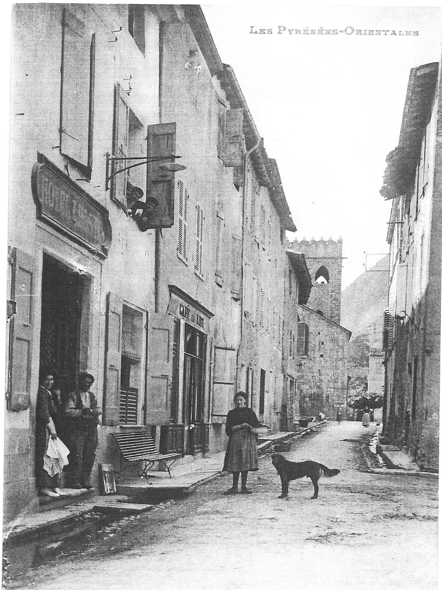
13. - VILLEFRANCHE-DE-CONFLENT. - RUE DE LA POSTE
